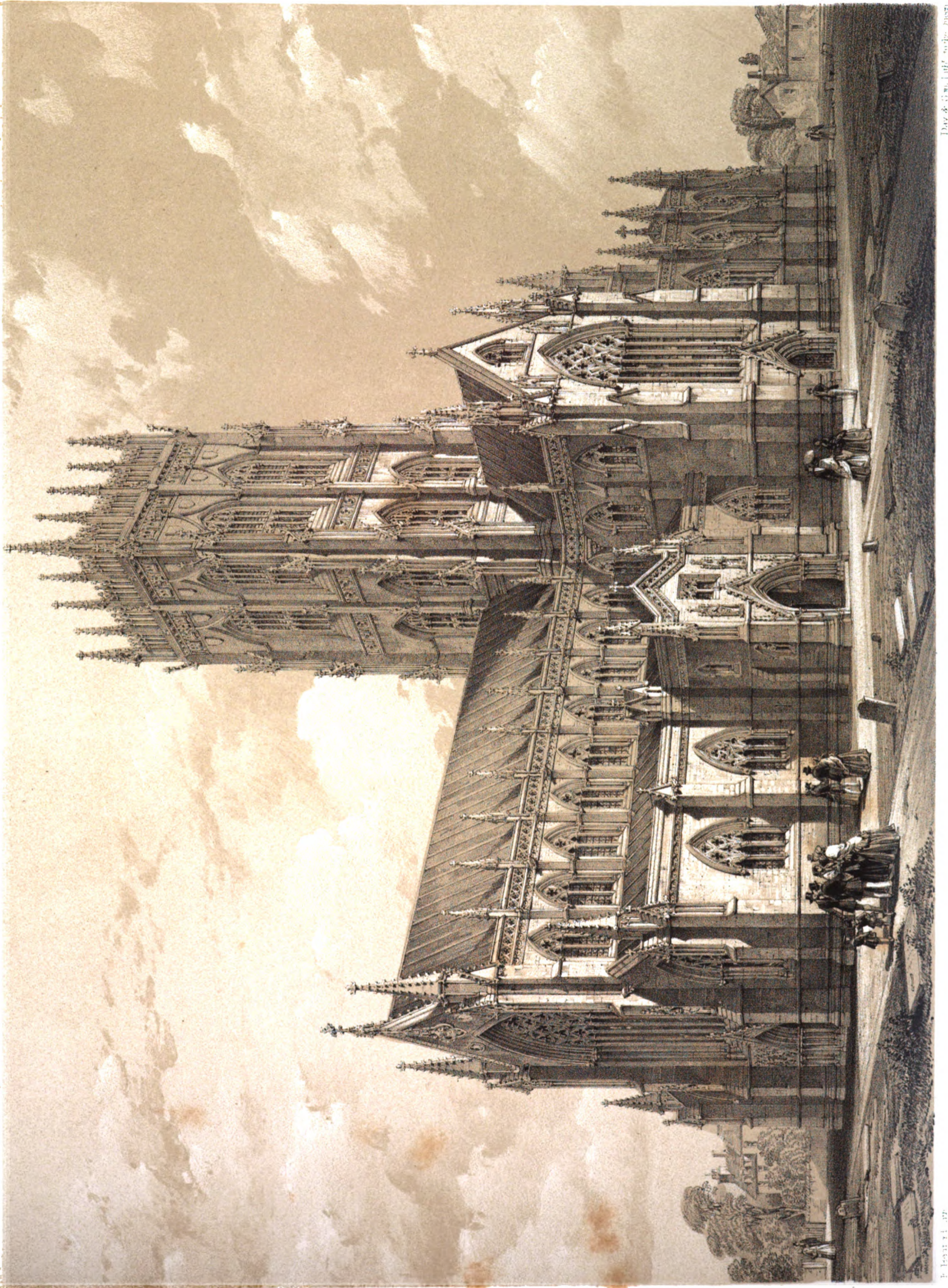
Das Westwerk der Kölner Kathedrale
